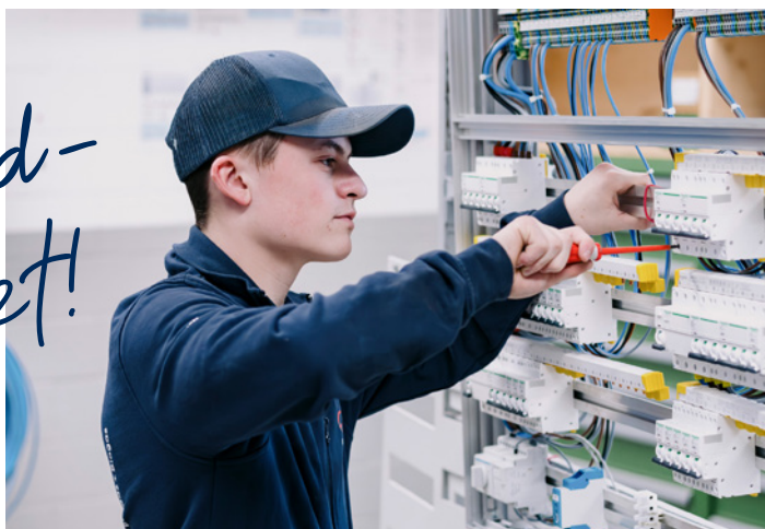
Auch vor dem Elektroverteiler: Der angehende Elektroinstallateur EFZ ist stets konzentriert bei der Sache.
