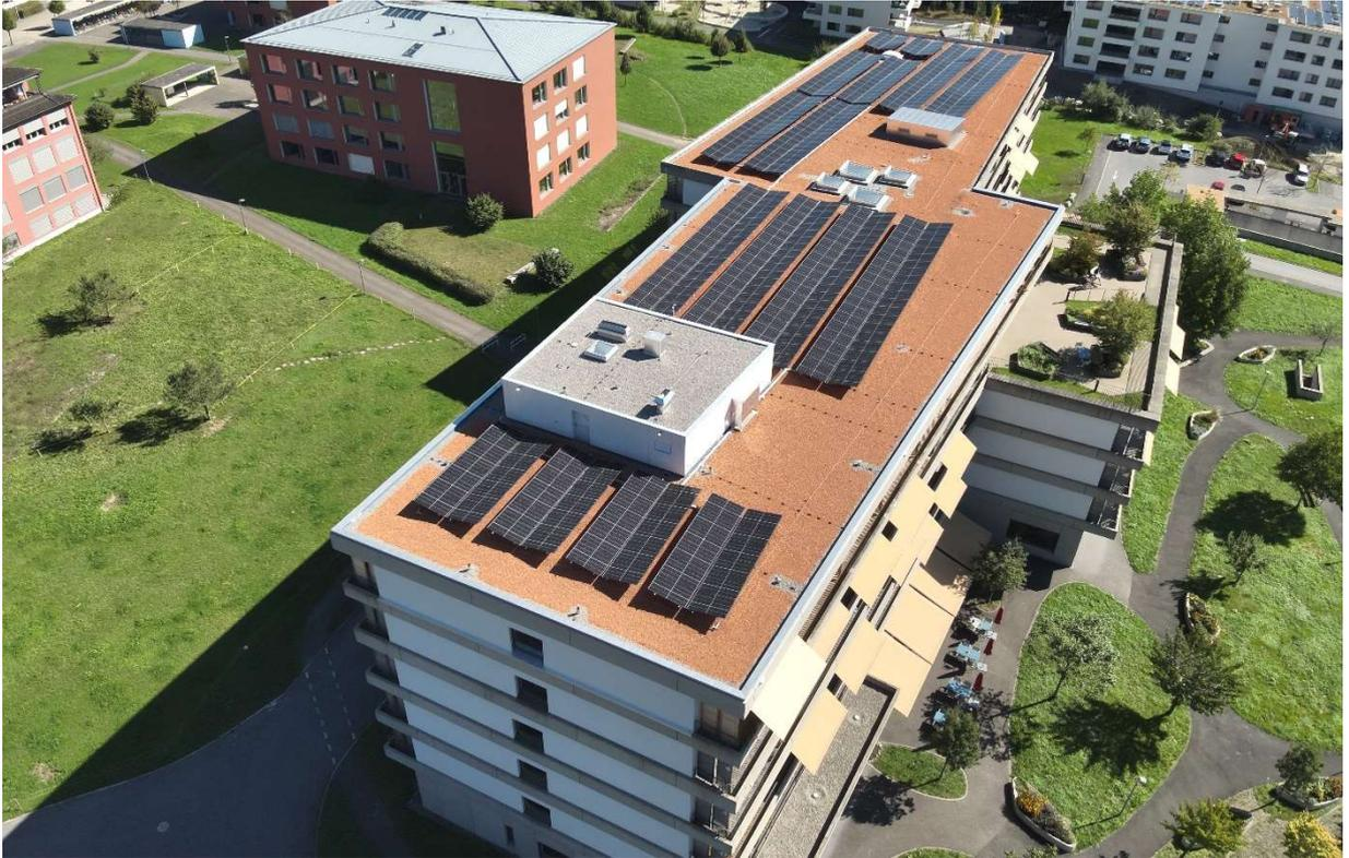
ebs erstellte auf dem Alterszentrum Rubiswil in Ibach eine eigene Photovoltaikanlage. Diese produziert jährlich rund 160'000 kWh umweltfreundlichen Strom, was dem Jahresbedarf von rund 35 Haushalten entspricht. Rund 70% der produzierten Solarenergie werden direkt vor Ort durch das Alterszentrum genutzt.
