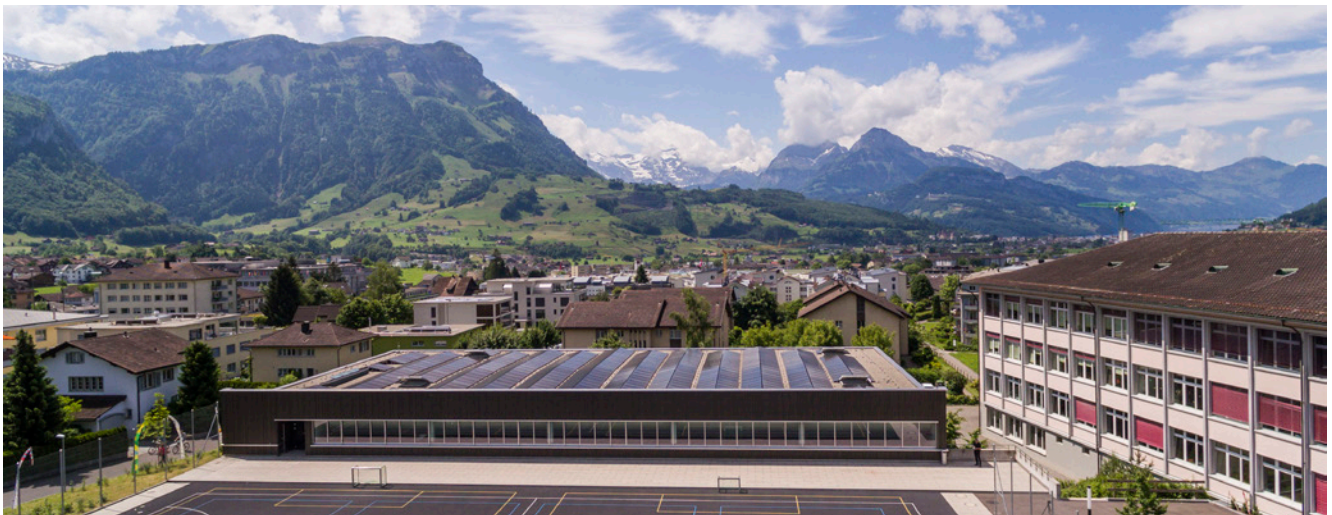
Die Photovoltaikanlage auf dem Dach der Turnhalle beim Schulhaus Lücken in Schwyz.
