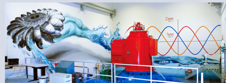
Neubau Wasserkraftwerk Steinerää in Steinen und Sattel (ebs Energie AG)
