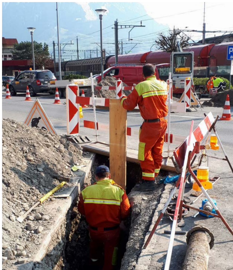
Reparatur der Gasleitung an der Bahnhofstrasse in Seewen
