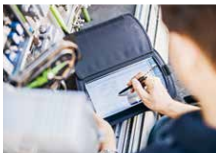
Sind alle Rohre richtig verlegt? Stefan Weber überprüft das mit Kollege Jörg Achermann (links) auf der Baustelle «Mythenhof» in Ibach.
